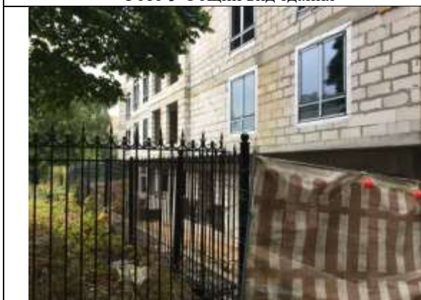
Фото 7 Общий вид здания
