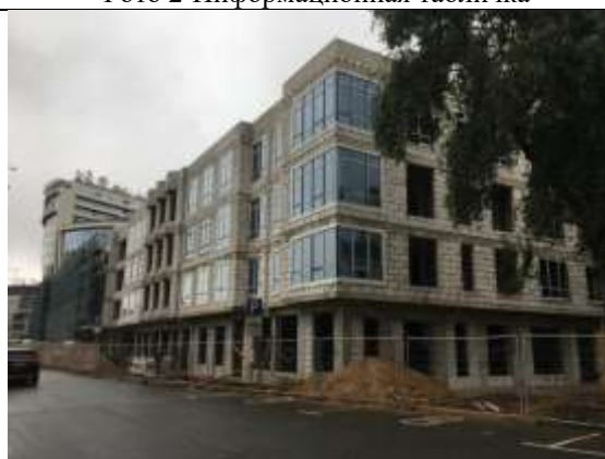
Фото 4 Общий вид здания
