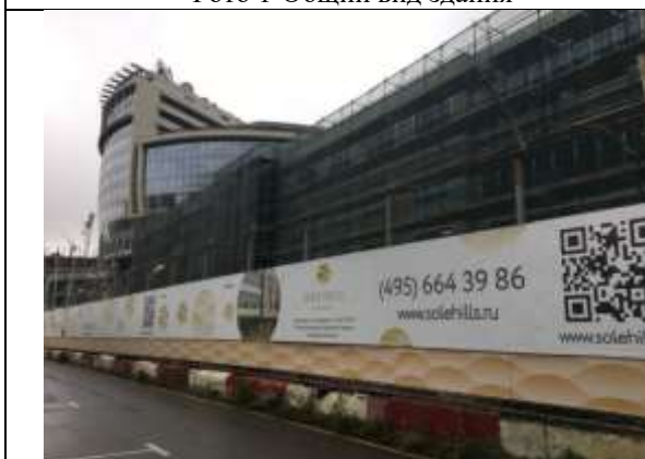
Фото 3 Общий вид здания
