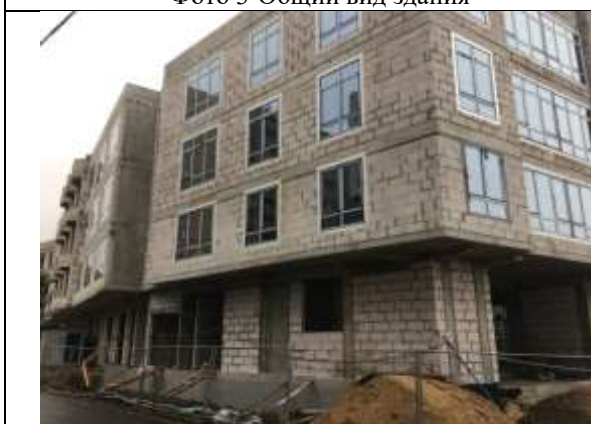
Фото 5 Общий вид здания
