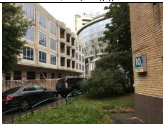
Фото 8 Общий вид здания
