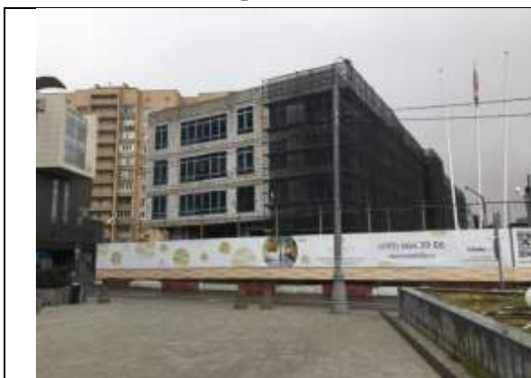
Фото 1 Общий вид здания
